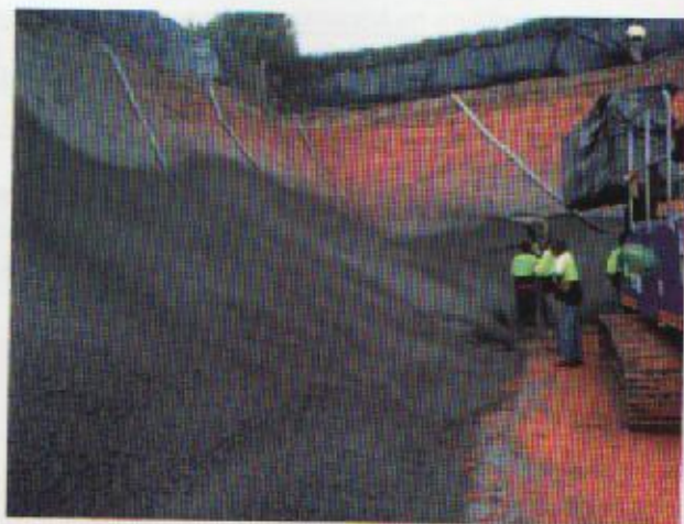
Figura 1. Concreto lanzado con fibra helicoidal para el recubrimiento de túneles y la estabilización de taludes.
